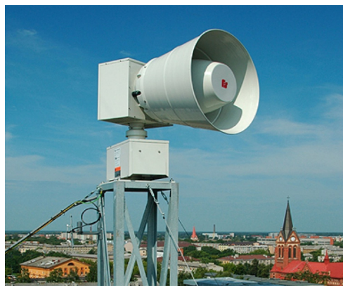
23 Sirēna uzstādīta uz pilsētas augstās ēkas plakanā jumta (avots: https://www.vugd.gov.lv/sites/vugd/files/kvp_130617_ts1.pdf )
